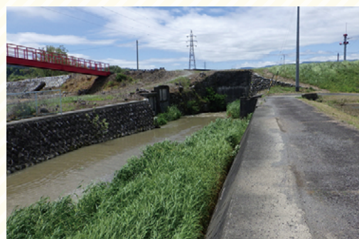
欠野川が土曾川の下を流れる。正面は上に土曾川、下に欠野川のトンネル。これも珍しい。天井川になったため、川の立体交差で天竜の増水時の逆流を防いでいる。
