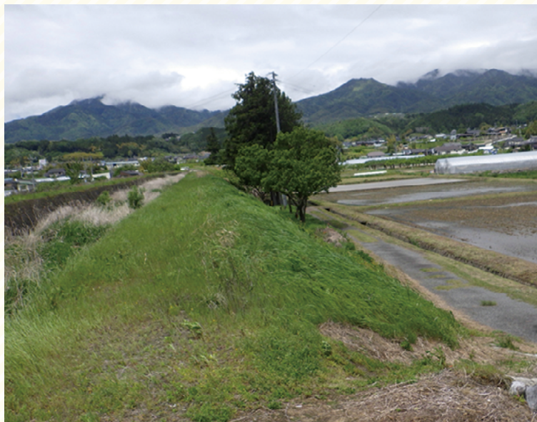
土曾川河口(天竜川合流地)から上流を見る。中央が土曾川左岸堤防、左に土曾川、右が天竜川面の水田地帯。堤防の上から左の川底まで約1.5 m。右の水田までは高さ約2.3 m。水田の方が低い。遠くに見えるのは座光寺富士。
