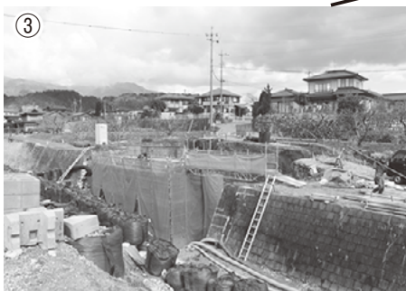
下羽場地区 土曾川の堂垣外橋の架替工事 (上郷側から撮影)
