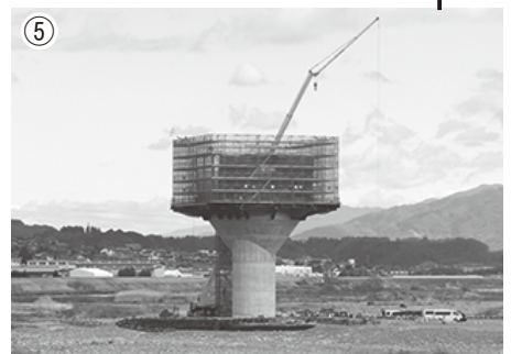
天竜川橋りょう工事 (喬木村側から撮影)
