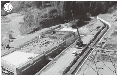
土曾川函渠工事 (土曾川大橋から撮影)
