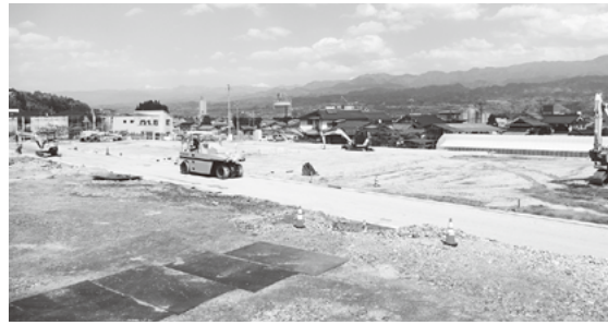
建設工事が進む唐沢宮の前地区代替地整備
