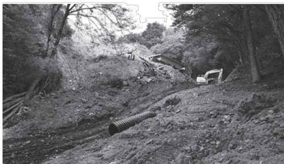
崩落のあった現場斜面
