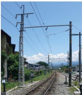
架線柱（線路左の鉄製柱）は伊那電開通時のもの。当初は緑色だったが、現在、多くは白く塗装されている
