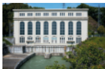
南向発電所(中川村)
