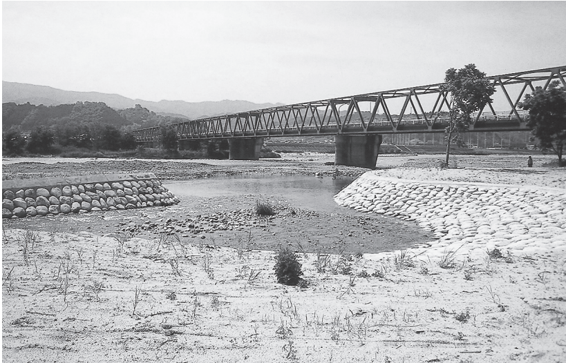
次の工事を待つ水辺の公園（南大島川と天竜川合流地点）
