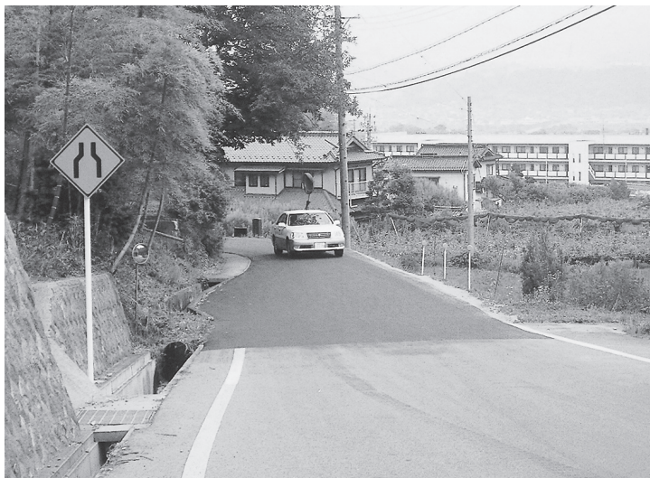
拡張工事が待たれる唐洞線
