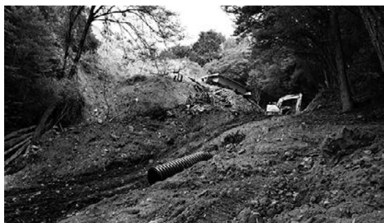
崩落のあった現場斜面
