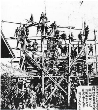
建設中の足場と村人
