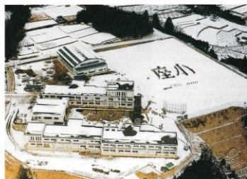
完成間近の新校舎全景（昭和59年）
