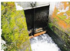
A-1 南大島川からの 本沢井取入口
