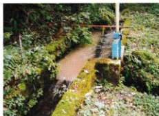
A-4 取入口に近い本沢 調節口(余水は南 大島川に返す)
