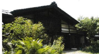
座光寺で一番古い本棟造 1716年（正徳6年）建築 北原家（穴野）
