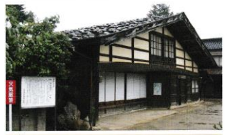
復元された石置き板屋根 1799年（寛政11年）建築 竹ノ内家（高森町）
