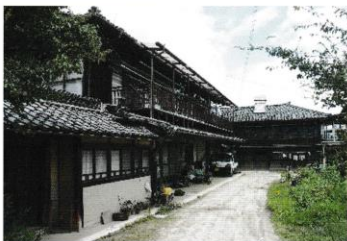
主屋と蚕室のある養蚕民家
