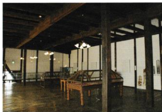
麻績学校校舎 1階内部 約15メートルの長い梁2本で二階を支えています。 —もとは1本の丸太を2つに割ったものです。 前脚2本の柱は修理のときに補強で入れた柱です。
