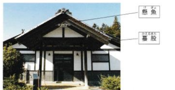
修理前の正面の玄関は、すぐ隣の「麻績の里交流センター」の裏口として移築されています。
