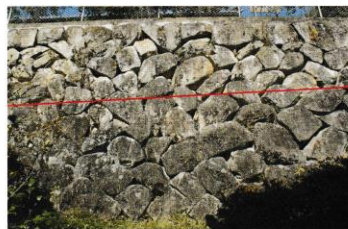
打ち込みハギの落とし積み
